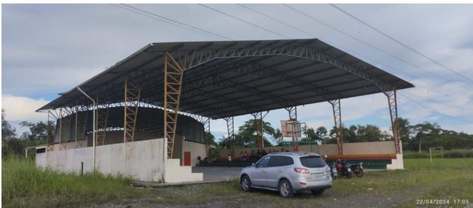
Fuente: Levantamiento de campo, equipo consultor Elaborado por: Equipo consultor, 2024
