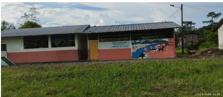
Fuente: Levantamiento de campo, equipo consultor Elaborado por: Equipo consultor, 2024
